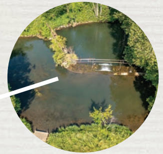
● Ouvrage de dérivation d'anciens moulins
